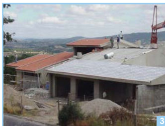
4ème Étape - Fixation des écarteurs transversaux a la longueur des tuiles
