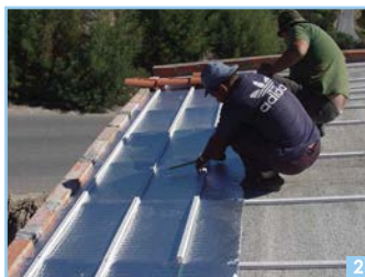
2ème Étape - Placement de Boltherm dans le sens longitudinal 3ème Étape - Seller les joints avec le ruban adhésif en aluminium
