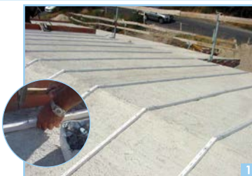
1ère Étape Fixation des écarteurs dans le sens ascendant
