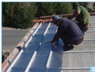
2ème Étape - Placement de Boltherm dans le sens longitudinal
